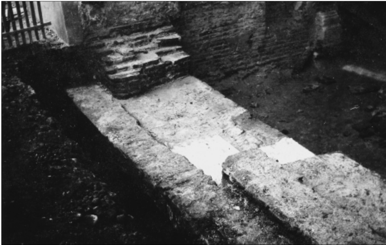
FIG. 4. CHAPELLE SAINT-NICOLAS. SOUBASSEMENT DU MUR SUD avec l'emplacement d'une ancienne porte, et le renforcement de l'ensemble de l'ouvrage survenu à la fin du XIV e siècle.
